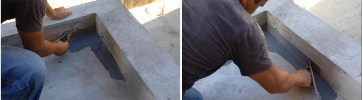
3.2. Para o encontro entre o piso e a parede, não é necessária a confecção de meia cana, deve-se deixar os cantos com 90º, porém RECOMENDAMOS o uso de tela de POLIÉSTER na aplicação da segunda demão até uma altura média de 30 cm, ou seja, 30 cm na parede e 30 cm no piso. Devem-se aplicar as mesmas quantidades de demãos recomendada para o sistema.
