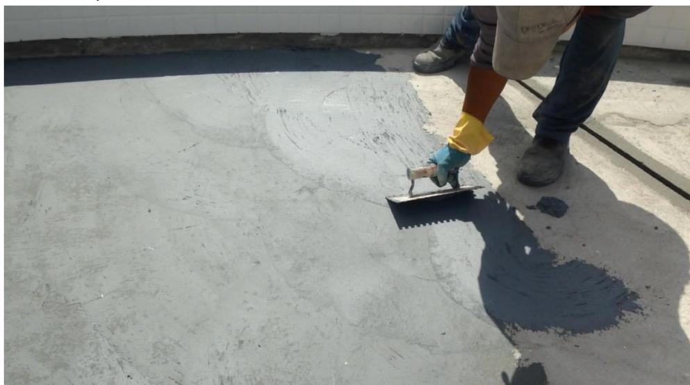
**OBS.:** Após a cura, que leva um tempo mínimo de 24 horas, aplicar a segunda demão e assim sucessivamente quantas demãos for necessário, sempre respeitando o tempo mínimo de 24 horas; Se for especificada o **uso de tela de poliéster**, esta deverá ser aplicada na segunda demão, conforme fotos abaixo.
