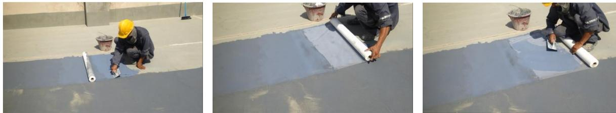
3.4. Após a aplicação da demão com a tela, aplicar a terceira demão e as demais, se houver, sempre respeitando o intervalo mínimo de 24 horas, conforme figura do item 3.2.;
