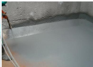
3.2. Para o encontro entre o piso e a parede, não é necessária a confecção de meia cana, deve-se deixar os cantos com 90º, porém RECOMENDAMOS o uso de tela de POLIÉSTER na aplicação da segunda demão até uma altura média de 30 cm, ou seja, 30 cm na parede e 30 cm no piso. Devem-se aplicar as mesmas quantidades de demãos recomendada para o sistema.
