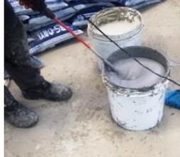
Após o produto diluído, aplicar em demãos finas, com intervalos mínimos entre demãos de três horas. Aplicar quantas demãos for necessário para utilizar todo o produto indicado para aquele tipo de área.
